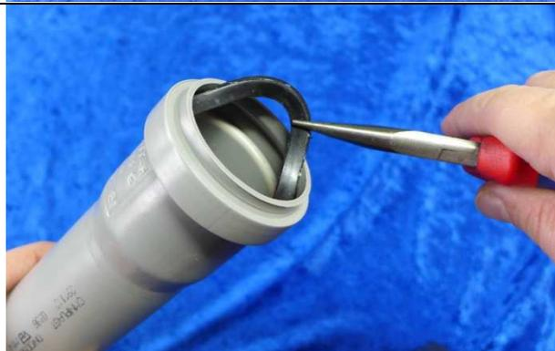
Als erstes entnehmen wir vorsichtig die Dichtungen der HT-Rohre. Aus dem T-Stück nehmen wir nur die Dichtung des Abzweigs raus. Wir greifen zur Zange, packen die Dichtung vorsichtig und ziehen diese aus der Führung. Alternativ zur Zange kann auch ein Schlitzschraubenzieher oder ein Spatel verwendet werden. Wir benötigen die Dichtung später noch, also bitte gut behandeln!
