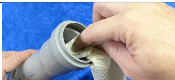
Wenn beide Ventilkörper fertig sind, wird zuerst der Körper für das gerade Rohr eingesetzt. Zur Erinnerung: Die HT-Dichtung muss entnommen sein! Im ersten Schritt wird das Rohr gesäubert. Das gilt vor allem, wenn sie ein gebrauchtes Rohr verwenden! Wenn da Sand im Rohr ist, kann das beim Einbau den O-Ring beschädigen!
